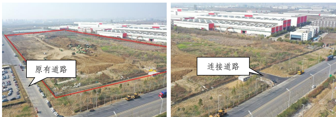
图 2.4 施工道路现状图
