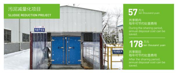
为充分处置危险废弃物,公司就污泥减量的技术方案进行多次研讨及可行性分析,采用低温箱式干燥技术进行空气脱湿 加热,污泥减量达56%。同时采用"合同环境管理"模式,设备由运营公司投入、运用利益共享。共享期内,每年可节约处 置费用57万元; 共享期后, 每年可节约178万元处置费用。
