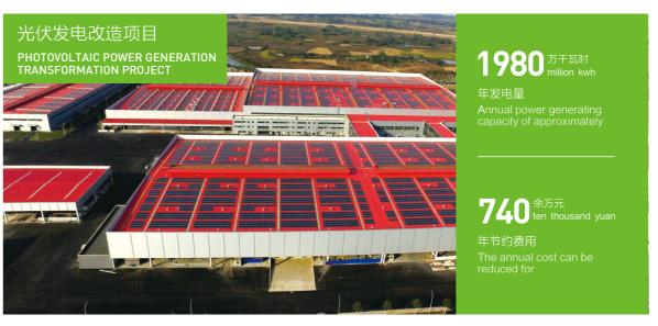
公司率先以乘用车二、三工厂为光伏发电试点单位,采用"自发自用,余电上网"模式,总装机容量18MW,年发电量 约1980万千瓦时,年节约费用约740余万元。公司新建新港项目投入7500万元,新建12MW六万块光伏电池组件光伏系统, 项目25年(光伏有效使用年限)总发电量36660万度,每年可为电网节约标准煤约4914.45吨。
