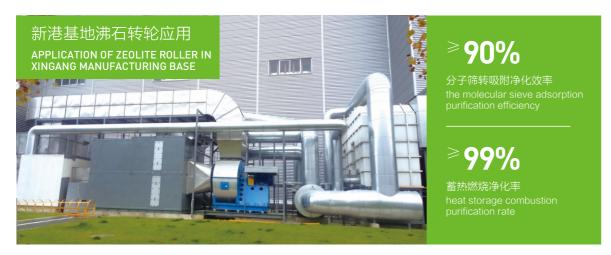
罩光漆喷漆室废气和罩光漆流平室废气,经文氏喷漆室处理后送至废气浓缩装置,有机废气物质进入疏水型沸石,吸附 效率92%以上。沸石转轮经热空气脱附后,进行直接燃烧处理。应用沸石转轮特点是净化效率高,分子筛转吸附净化效率≥ 90%, 蓄热燃烧净化率≥99%, 可完全达标排放。
