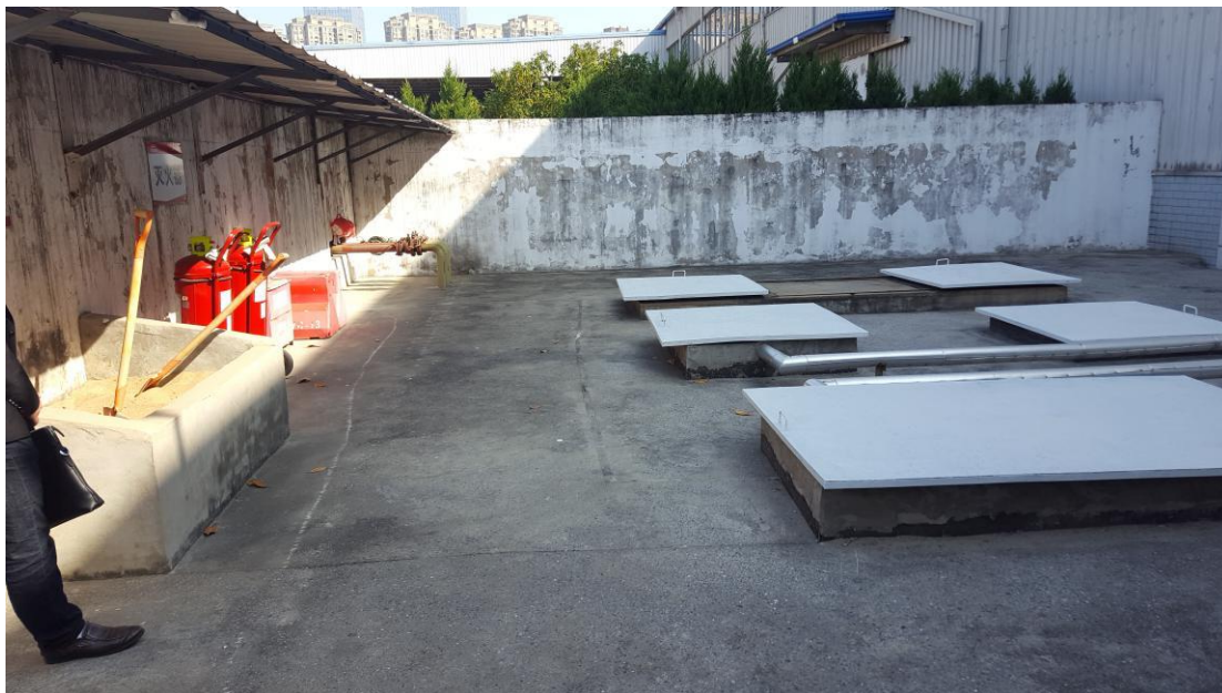
图 3.2-1 地下石油储罐区
