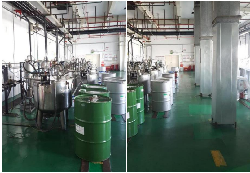
图 3.2-5 涂装车间调漆间
